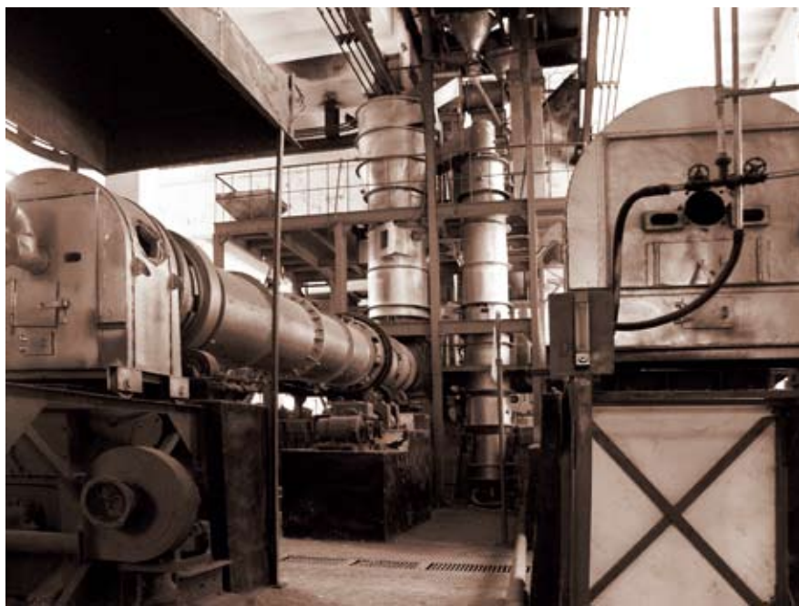
中国建材总院研制的水泥煅烧窑外分解技术，奠定了新型干法水泥技术的基础。图为试验窑，现被中国工业博物馆收藏
