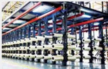
在青海西宁建设我国规模最大年产2万吨高性能碳纤维生产基地
