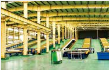
在安徽合肥建成世界单体规模最大的“一窑五线”超白高透光伏玻璃生产线
