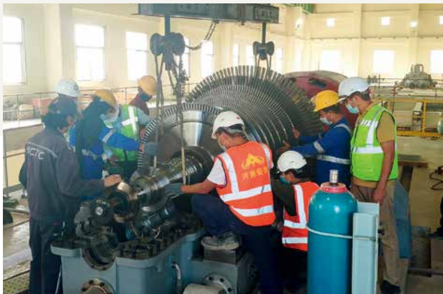
正在进行汽轮机的安装
