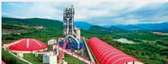
在浙江湖州槐坎自主建设日产7500吨水泥智能工厂——“高端化、智能化、绿色化、集约化”熟料生产基地
