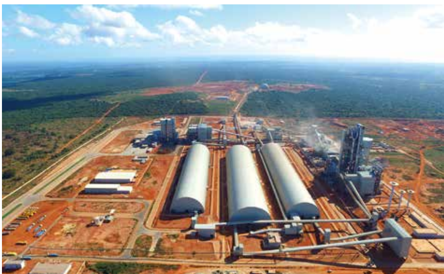
中材国际坦桑尼亚分公司Dangote水泥厂项目
